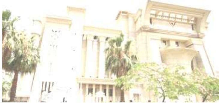
صورة (٦) الواجهة الجانبية
