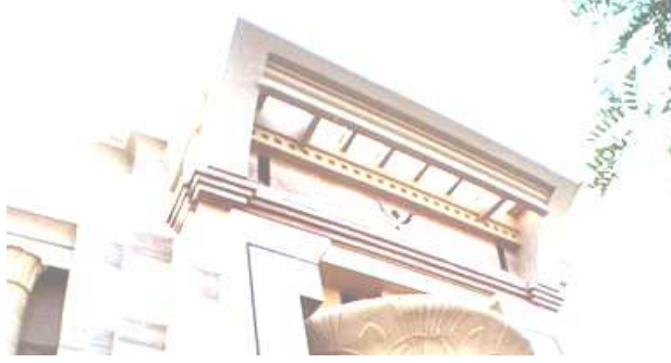
صورة (٨) شكل آخر للكورنيش بمبنى المحكمة
